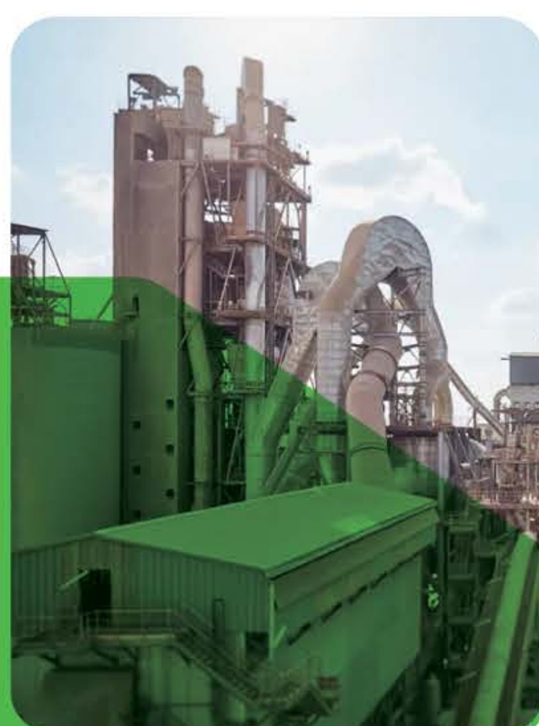
LafargeHolcim Fès Filtre broyeur clinker
