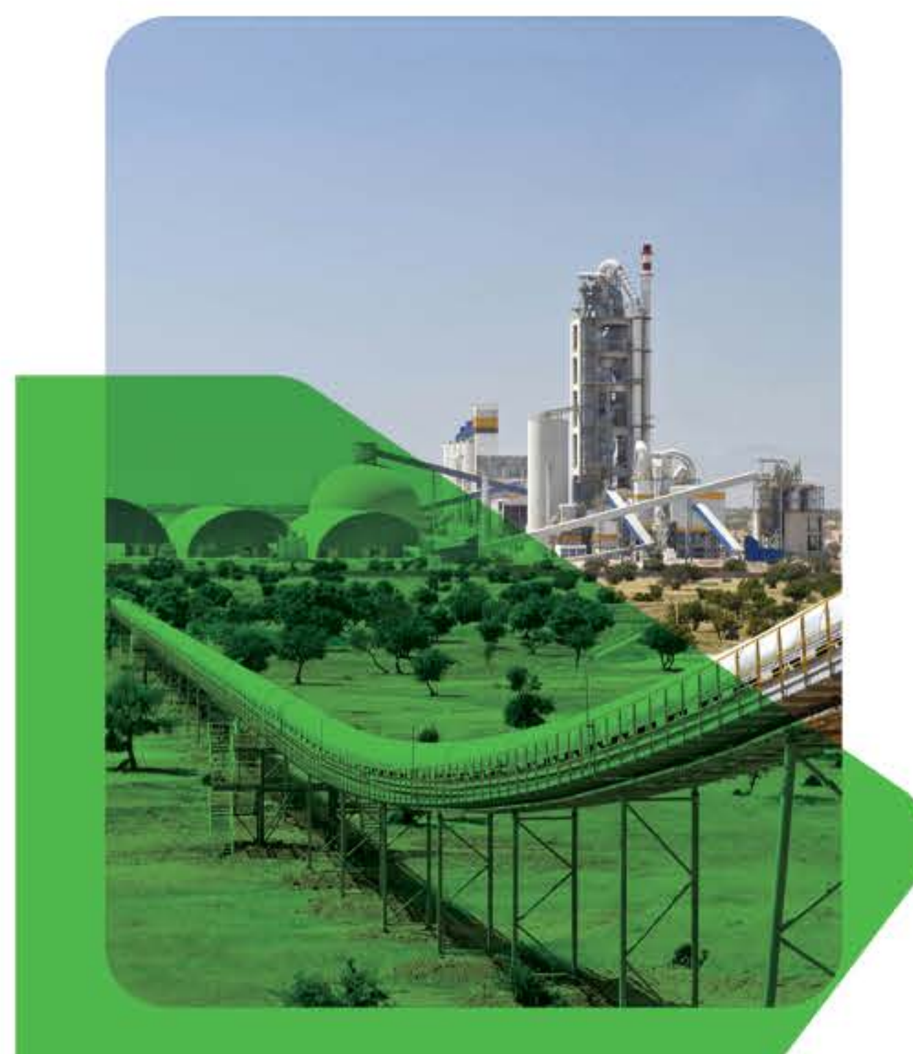
Ciments du Maro Maintenance filtres à manches (Aït Baha, Marrakech)
