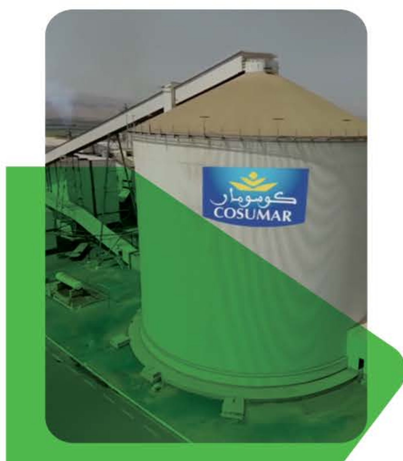
COSUMAR Maintenance complète des systèmes de filtratio
